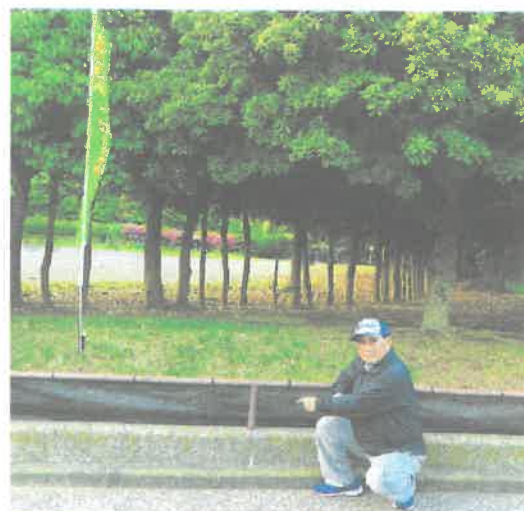
▲防護ネットを設置
